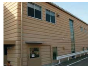
外壁塗装工事(三木工場)
