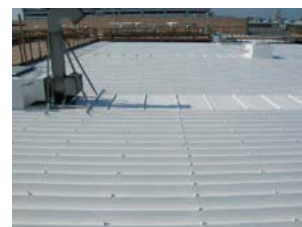
屋根遮熱塗装(三木工場)
