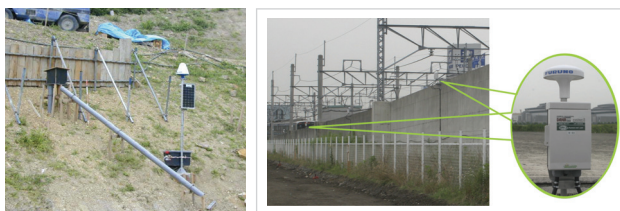
(左) 地すべり対策 (中左) 土木工事の施工管理 (中右、右) ダムや鉄塔など構造物の維持管理
