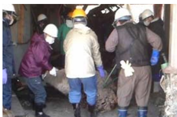
事業所再開に向けての がれき撤去作業
