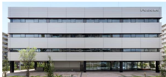
研究開発棟 SOUTH WING
