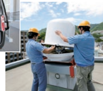
ワンボックス車やエレベーターを使って運搬し、人力で取り付けることができます。
